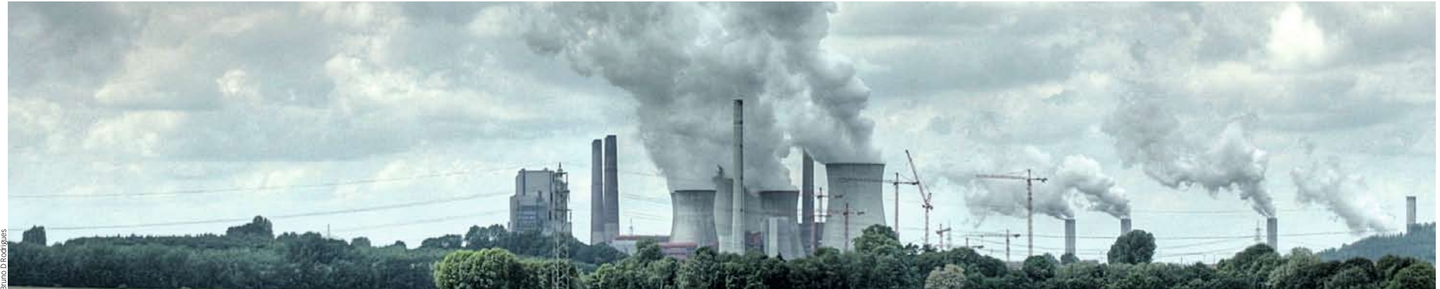
Ci-dessus une centrale électrique à charbon, à Neuss (Düsseldorf)
